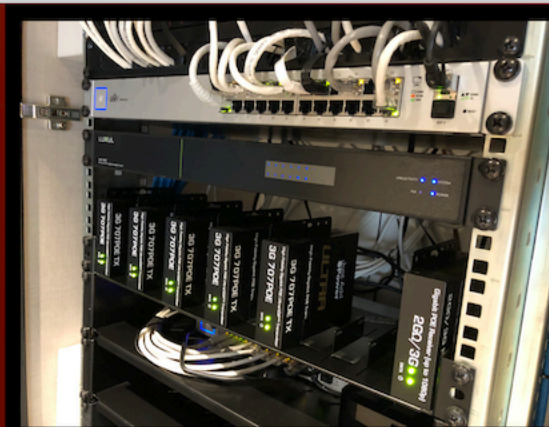
Da sinistra: l'esterno della casa; il telecomando RTI T1B+; un ambiente della casa. Sotto, uno scorcio del rack: visibili lo switch Luxul e i trasmettitori Just Add Power
